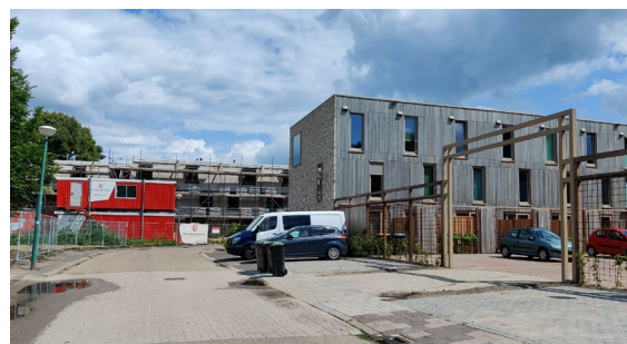
Transformatie (van kantoren) naar wonen op het terrein Princenhof, al voltooid (voorground) en nog in de realisatiefase (achtergrond).
