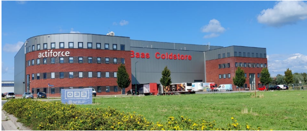
Gedeeld pand van Actiforce (kantoor) en Baas Coldstore (vrieshuis) op Haarbrug Zuid. Een van de vele panden dat dit terrein tot een voorbeeld maakt van intensief en meervoudig ruimtegebruik.
